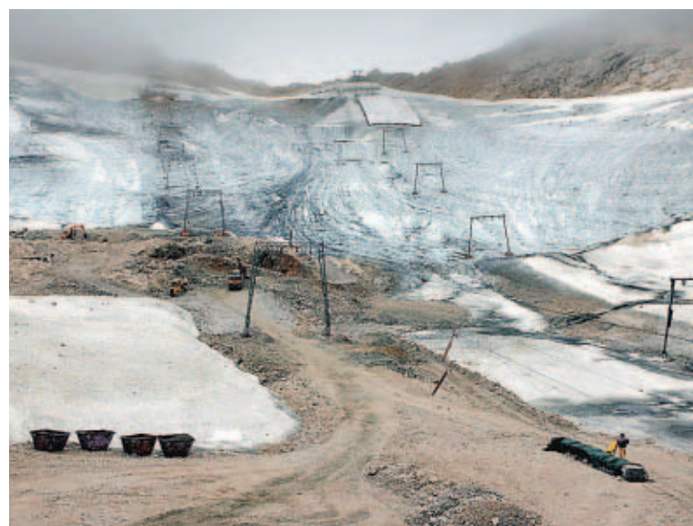
Ende der Eiszeit auf der Zugspitze: Der Gletscher schmilzt auch hier ab, die Liftmasten müssen neu verankert werden. Foto: ddp
